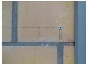
5. Montez les crochets jusqu'à ce qu'ils sortent +/- 1 cm du mur. Utilisez un insert adapté pour aller plus vite.
