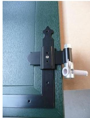
Enlever le nœud et désaccoupler le gabarit. Assembler les éléments du gond avec le nœud . Appliquer le scellement, insérer le gond et laisser durcir.
