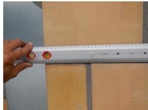
4. Réglez la profondeur de perçage de votre perceuse à 50 mm. Avant de percer, assurez-vous de ne pas percuter des conduits d'eau, de gaz ou d'électricité. Percez avec une mèche de 8 et montez les chevilles.
