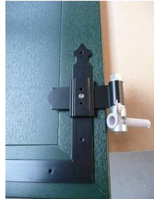
5. Enlever le nœud et désaccoupler le gabarit. Assembler les éléments du gond avec le nœud .Appliquer le scellement, insérer le gond et laisser durcir.
